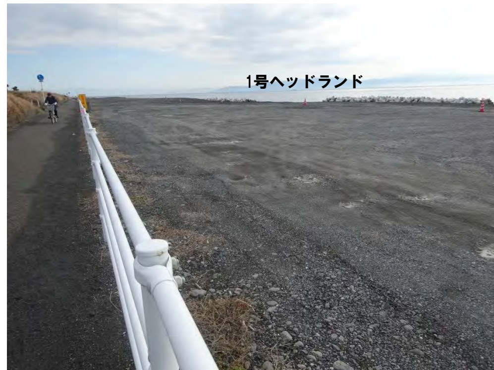
駒越地先 サンドバイパス実施後（平成27年2月3日）
