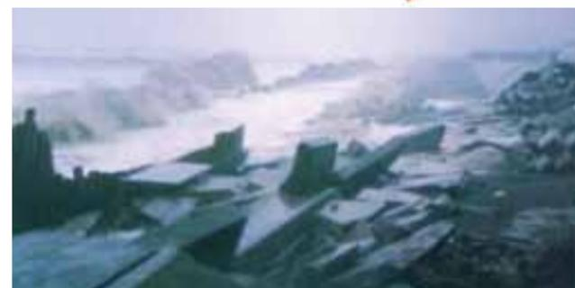
台風による海岸護岸の被災(昭和58年 静岡市清水区蛇塚)
