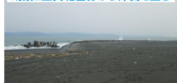
被覆ブロック張式の縦堤は地形への追従性、砂浜との馴染みのよさから縦堤が目立ちにくい
