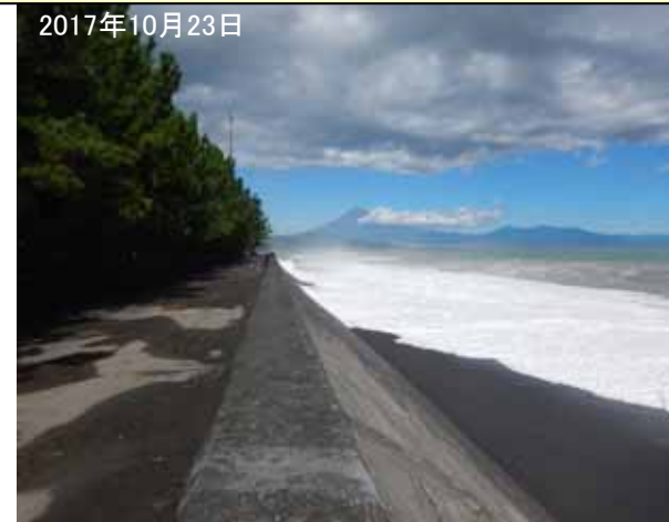
1, 2号消波堤背後の堤防状況
