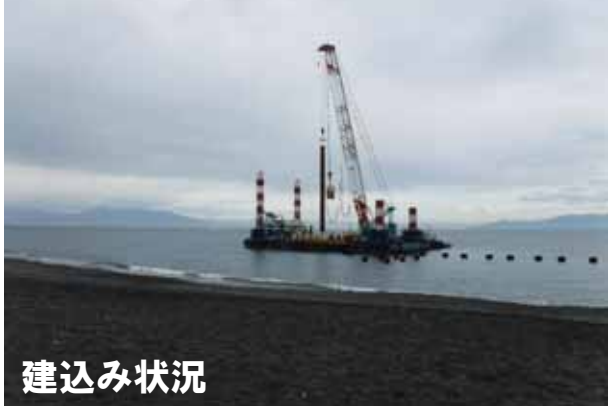
バイプロハンマ打設状況
