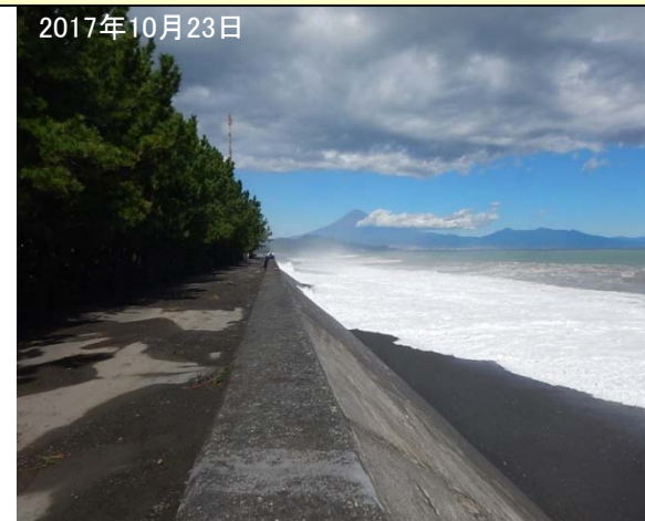
1, 2号消波堤背後の堤防状況
