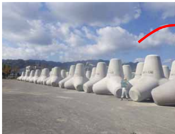
【既設L型突堤復旧工事中】 消波ブロック製作
