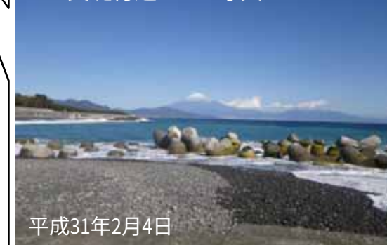
L型突堤付近からの写真
