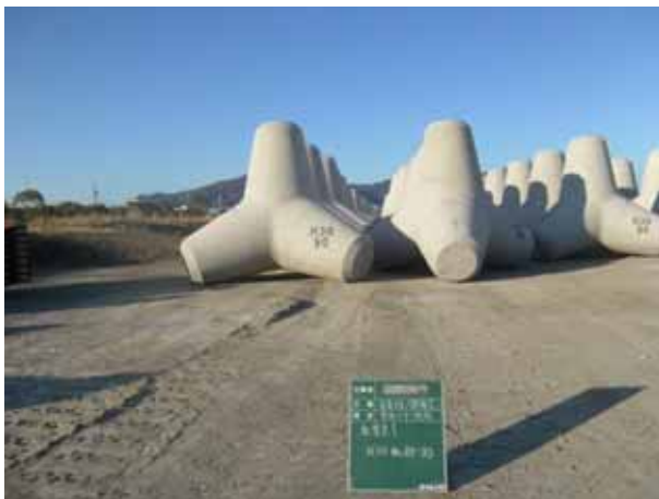
【2号消波堤復旧工事中】 消波ブロック製作
