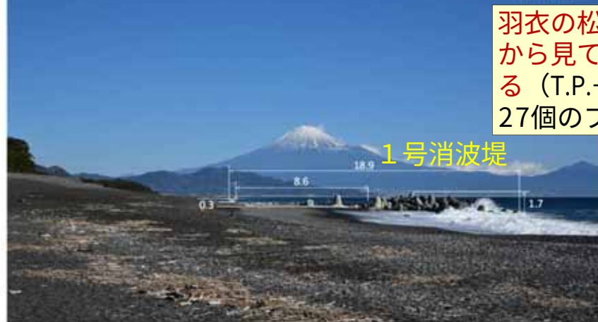
1号消波堤（ブロック撤去前）
