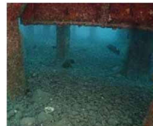
H27-2ブロック内部
