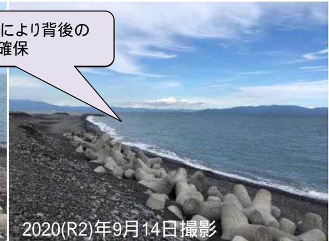
根固工の沖出しにより背後の養浜スペースを確保
