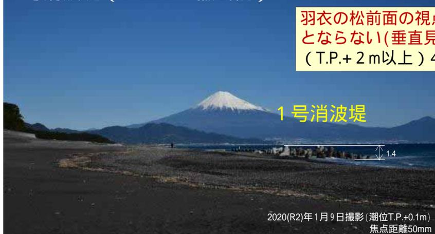
羽衣の松前面の視点場から見て景観の阻害要因とならない(垂直見込角1度以下)高さまで撤去(T.P.+2m以上)45個のブロックを撤去
