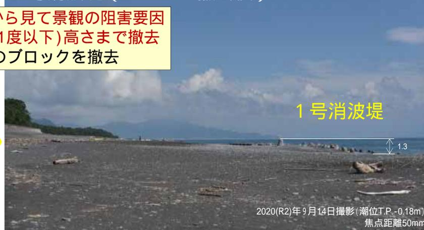
撤去した消波ブロック45個を3号ヘッドランド下手の消波工の嵩上げに転用
