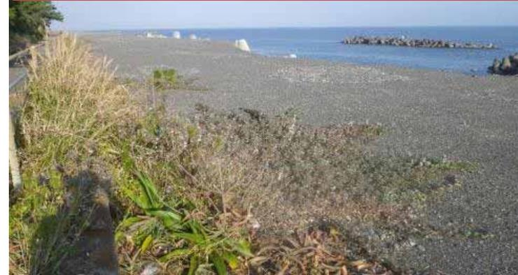
消波施設と継続的な養浜による侵食対策の効果によって護岸の安定化が図られている
