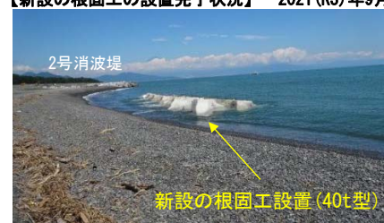
【新設の根固工の設置完了状況】 2021(R3)年9月
