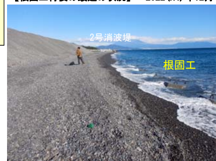
【根固工背後の最近の状況】 2022(R4)年12月
