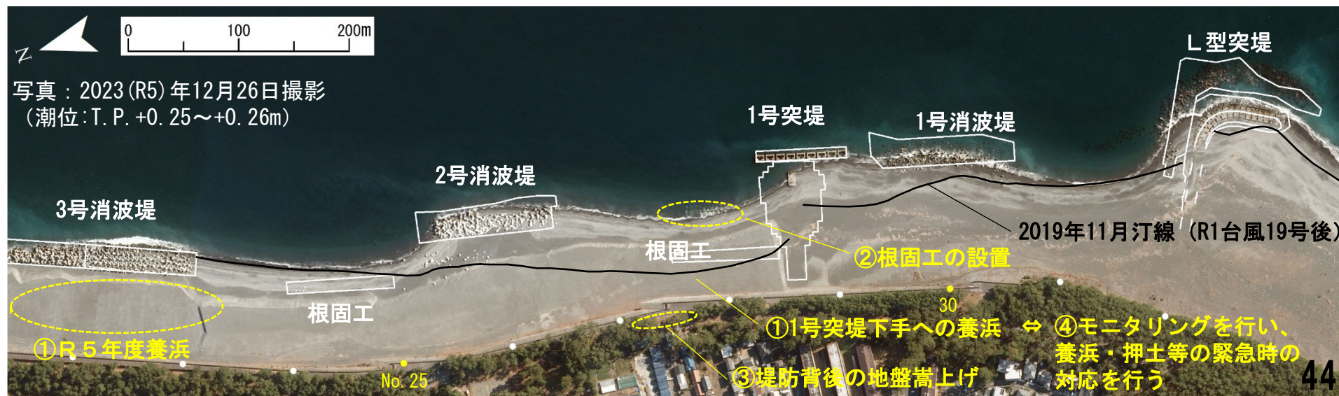
1号突堤周辺の状況
