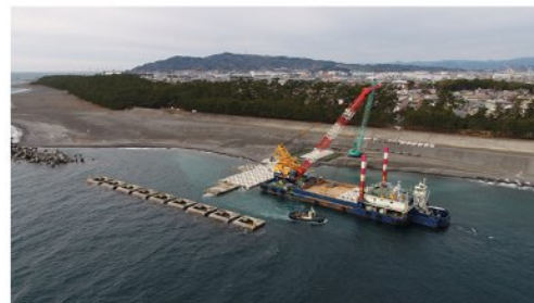
1号突堤施工状況(縦堤被覆ブロック設置状況)
