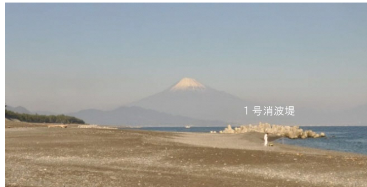
景観上の問題が指摘された消波堤 (2013(H15)年12月撮影)
