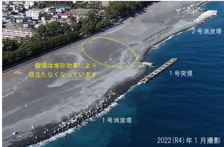
1号突堤の設置状況
