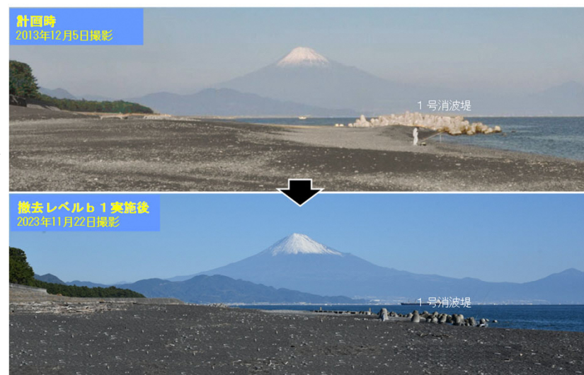
図 1.5 景観対策としての1号消波堤のブロック撤去 (第10回FU会議資料)
