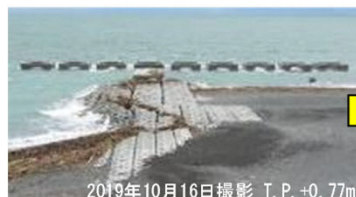
2019年度縦堤中央部の測線No. 6による天端高の確保状況確認（2020は測量未実施）
