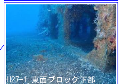
コンクリート組立礁 (設置年H27-1, H27-2) 設置水深30m
