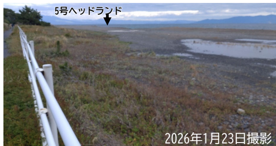
4号～5号ヘッドランド区間の状況（折戸地先）
