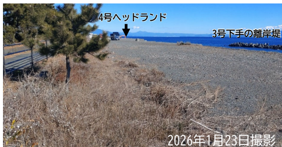
3号～4号ヘッドランド区間の状況（折戸地先）
