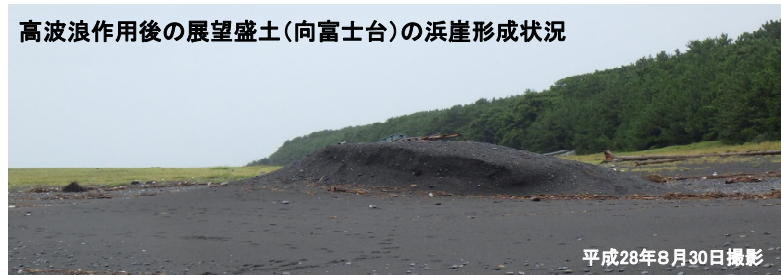
図 2.37 高波浪作用後の展望盛土（向富士台）の浜崖形成状況（2016年8月30日）
