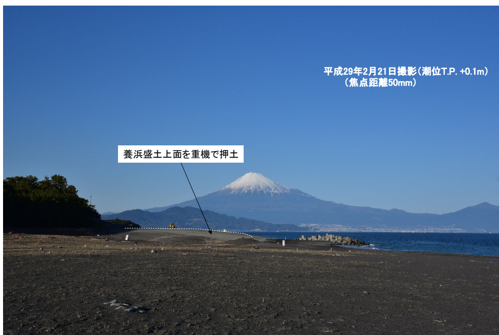
図 2.36 養浜盛土の形状修正状況（修正施工時の状況） 羽衣D
