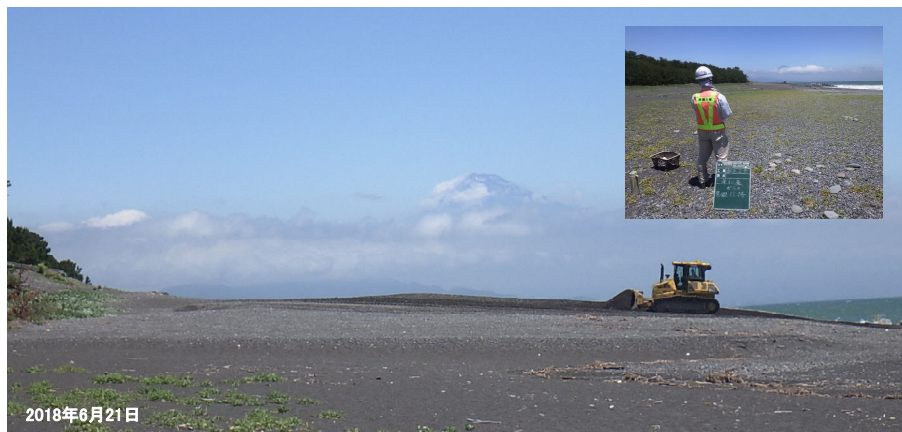
図 2.41 養浜盛土の修形状況 (2018 年 6 月 21 日)
