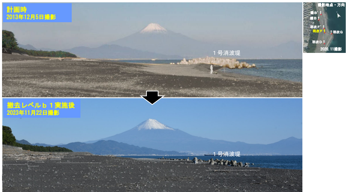
図 2.62 消波ブロック撤去前後の状況（計画時から撤去レベルb1実施後の変化）
