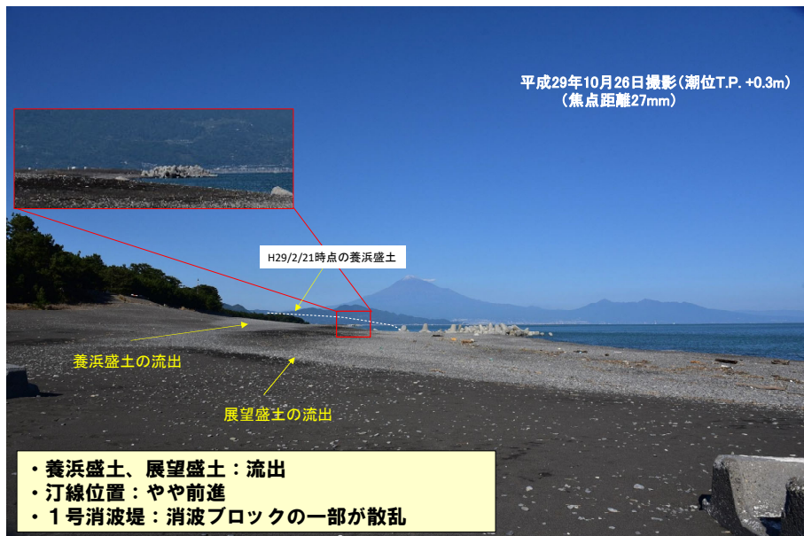
図 2.38 養浜盛土および展望盛土の変化状況（2017年台風21号後） 羽衣F
