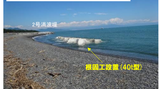
【根固工の設置完了状況】2021(R3)年9月
