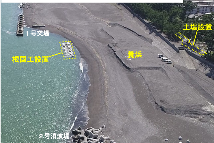
【2019年台風19号後の応急対策施設設置状況】2021(R3)年9月
