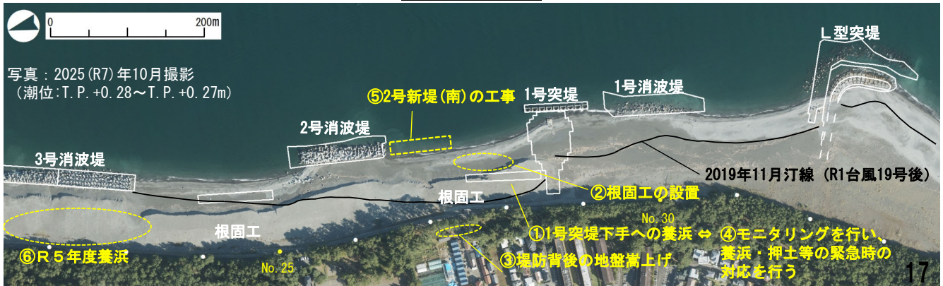
1号突堤周辺の状況
