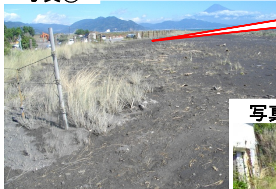
写真① 越波による流木の散乱状況
