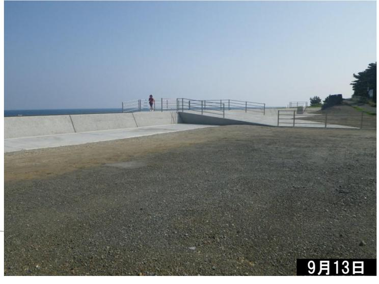
・堤防前面まで波浪が遡上したが、堤防嵩上げにより越波被害は生じていない
