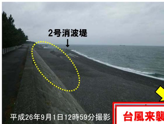
1号消波堤～2号消波堤間の養浜盛土が大きく削られ、堤防基部まで波が遡上した
