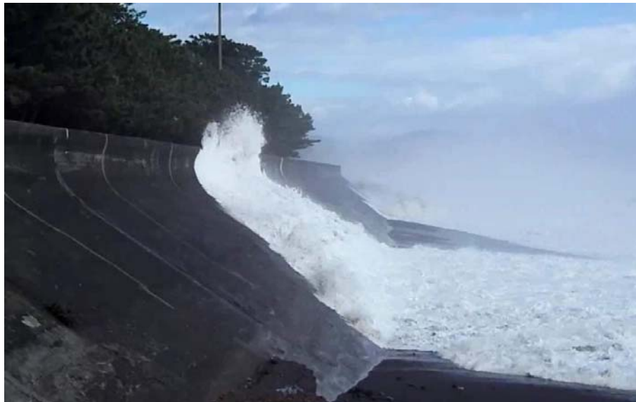
写真－ 4.1 平成 25 年 10 月台風 26 号来襲時の状況
