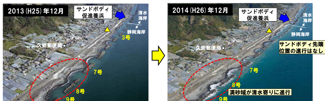
図－ 4.26 空中写真撮影（斜め）
