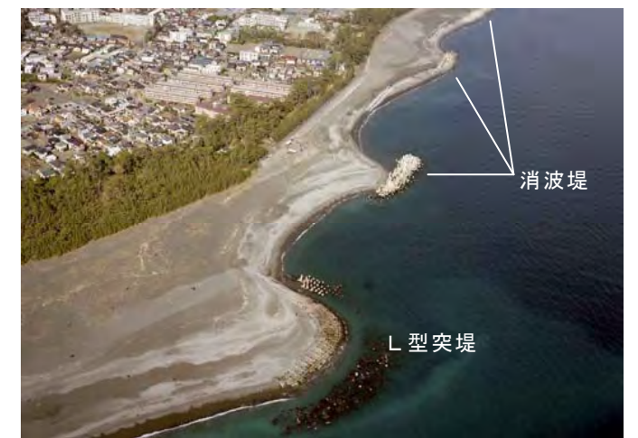
海岸構造物設置状況(清水海岸三保地区)
