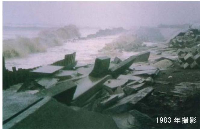
写真-2.1 国道150号の被災（蛇塚地区）
