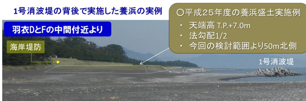
写真-6.2 養浜によって海岸堤防の視認性を低下させた事例（平成25年度施工）
