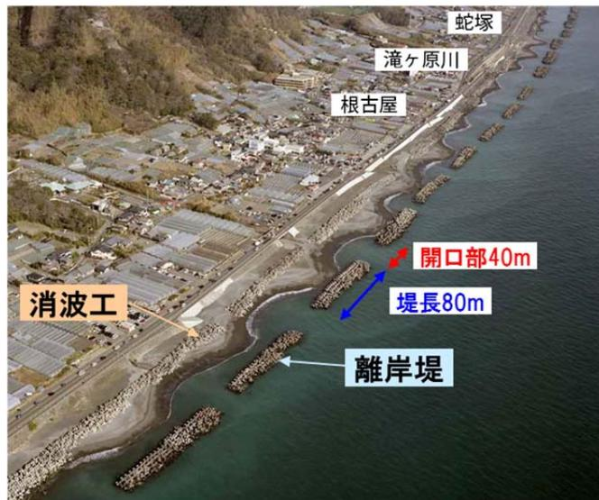
写真-2.2 静岡海岸の離岸堤と消波工
