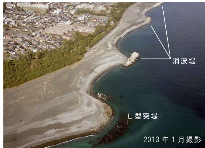
海岸構造物設置状況（三保地区）
