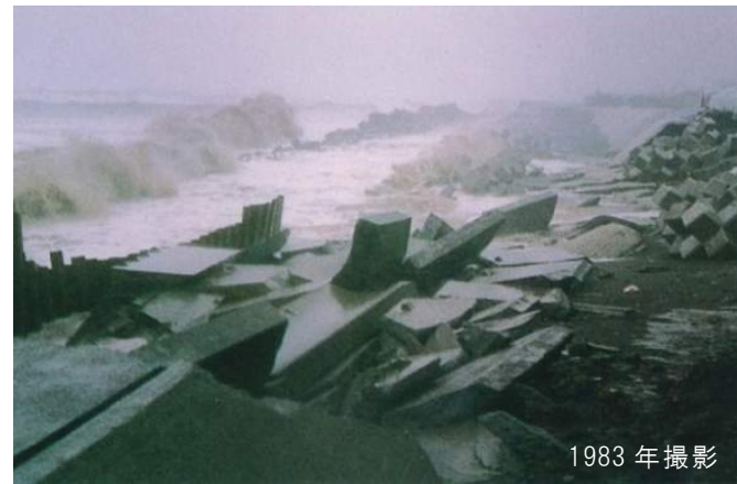
国道150号の被災（蛇塚地区）
