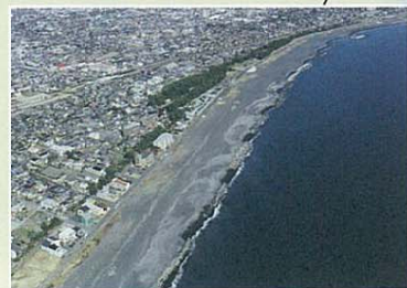
静岡海岸(西島地区)付近
