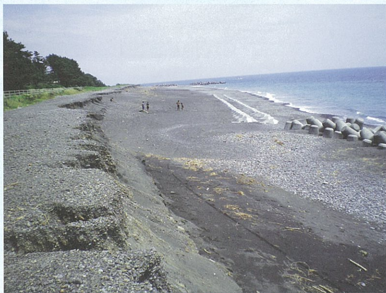
折戸で発生した「浜がけ」(平成23年7月)
