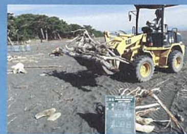
▲羽衣の松周辺の流木撤去工事
