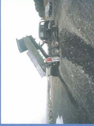
【養浜】 人工的に砂を補給して砂浜の維持、回復を図る工法。
