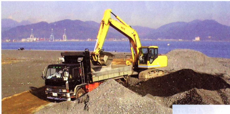
土砂採取状況(三保飛行場前)
